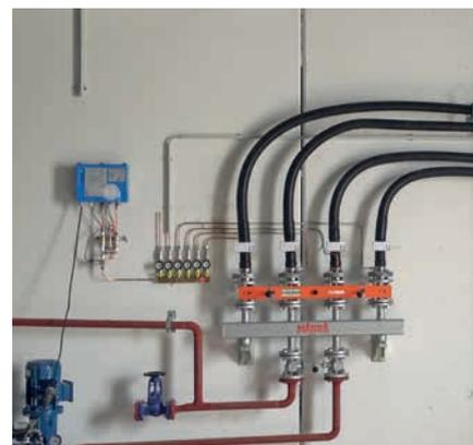
Fertig montiertes Leckanzeigesystem mit Ferndiagnose
