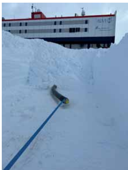
Maintien du tube au milieu de la tranchée
