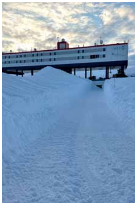
La tranchée avec pente est terminée, longueur environ 50 m
