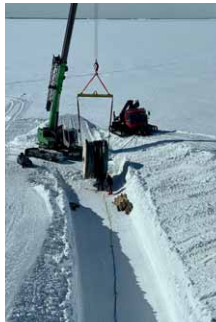
Déroulement à l'extérieur avec des sangles
