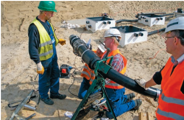
Montage einer Anschlussverbindung
