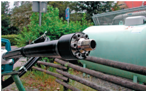
Montierte FLEXWELL®-LPG- Anschlussverbindung
