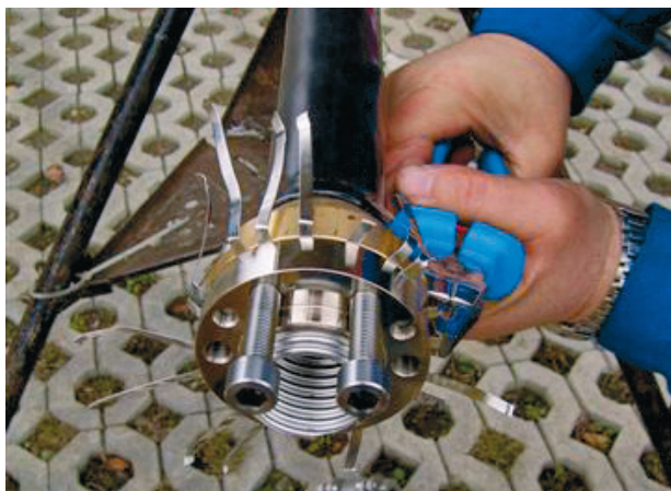
Straffen der FLEXWELL®-LPG- Armierungsbänder
