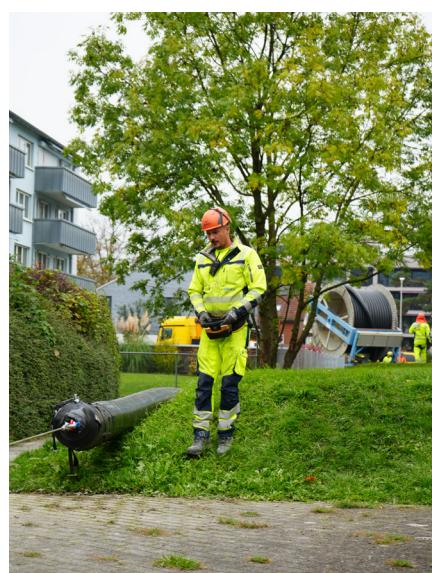
L'attraversamento del torrente è stato realizzato con l'ausilio di tubi vuoti posati in precedenza, attraverso i quali sono stati poi inseriti i sistemi di tubazioni BRUGG. Grazie all'esclusiva struttura con rivestimento in acciaio di FLEXWELL-FHK, questa soluzione è stata realizzabile a livello mondiale solo con questo sistema.
