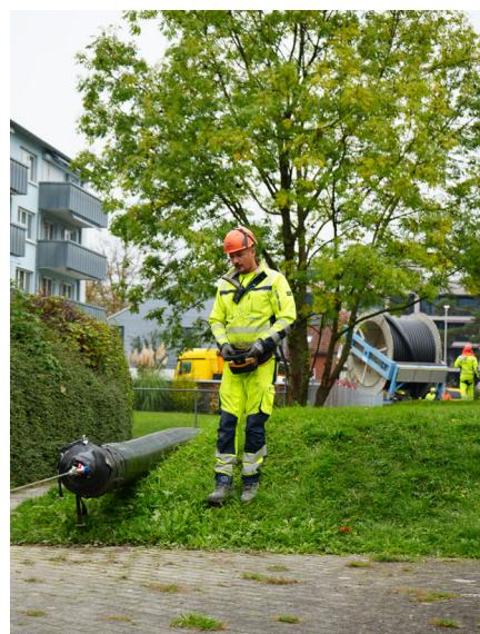
Die Bachunterquerung wurde mithilfe von vorgängig verlegten Leerrohren realisiert, durch die anschliessend die BRUGG-Rohrsysteme eingezogen wurden.
