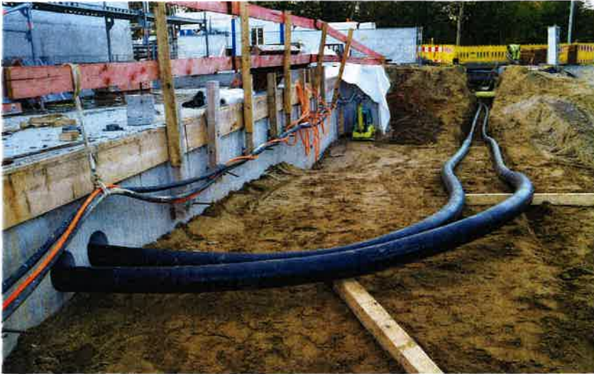
Bild 4. Die letzten 44 m von der Hauptstraße ins Gebäude wurden in offener Bauweise verlegt
