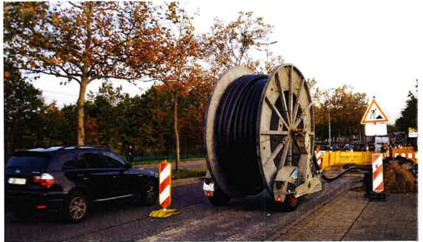
Bild 1. Das Flexwell-Fernheizkabel kann in einer maximalen Länge vom 1000 m am Stück gefertigt und auf riesigen Kabeltrommeln gewickelt individuell an jeden Einsatzort transportiert werden Quelle: Brugg Rohrsysteme
