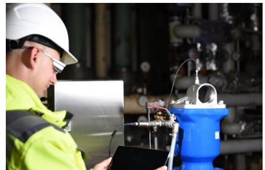
Installation eines VAG DUOJET® @ON Smarten Be- und Entlüftungsventil in einem Schacht. © GF
