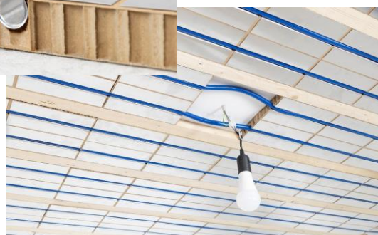
Montage des Flächenheizungssystems aus Altpapier: IDEAL CLASSIC CAB 30. © mfh systems
