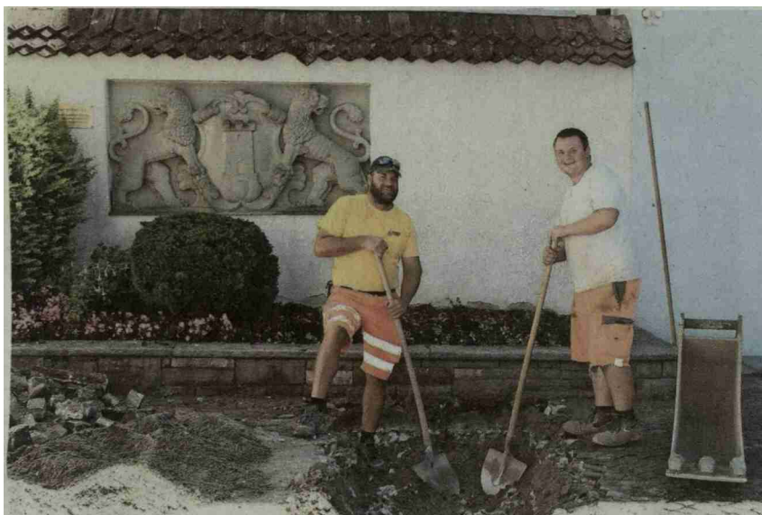
Mit den Vorbereitungsarbeiten auf dem Rathausplatz haben Urs Inderbitzin und René Gwerder von der Bürgi Tiefbau AG bereits begonnen. Bilder: Werner Geiger
