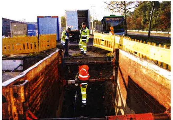
Eine Baugrube jeweils am Anfang und Ende der zu verlegenden Fernwärmeleitung genügen. Das bis zu 1000 Meter lange „Kabel“ wird auf einer Trommel geliefert und auf einen Rutsch verlegt.
