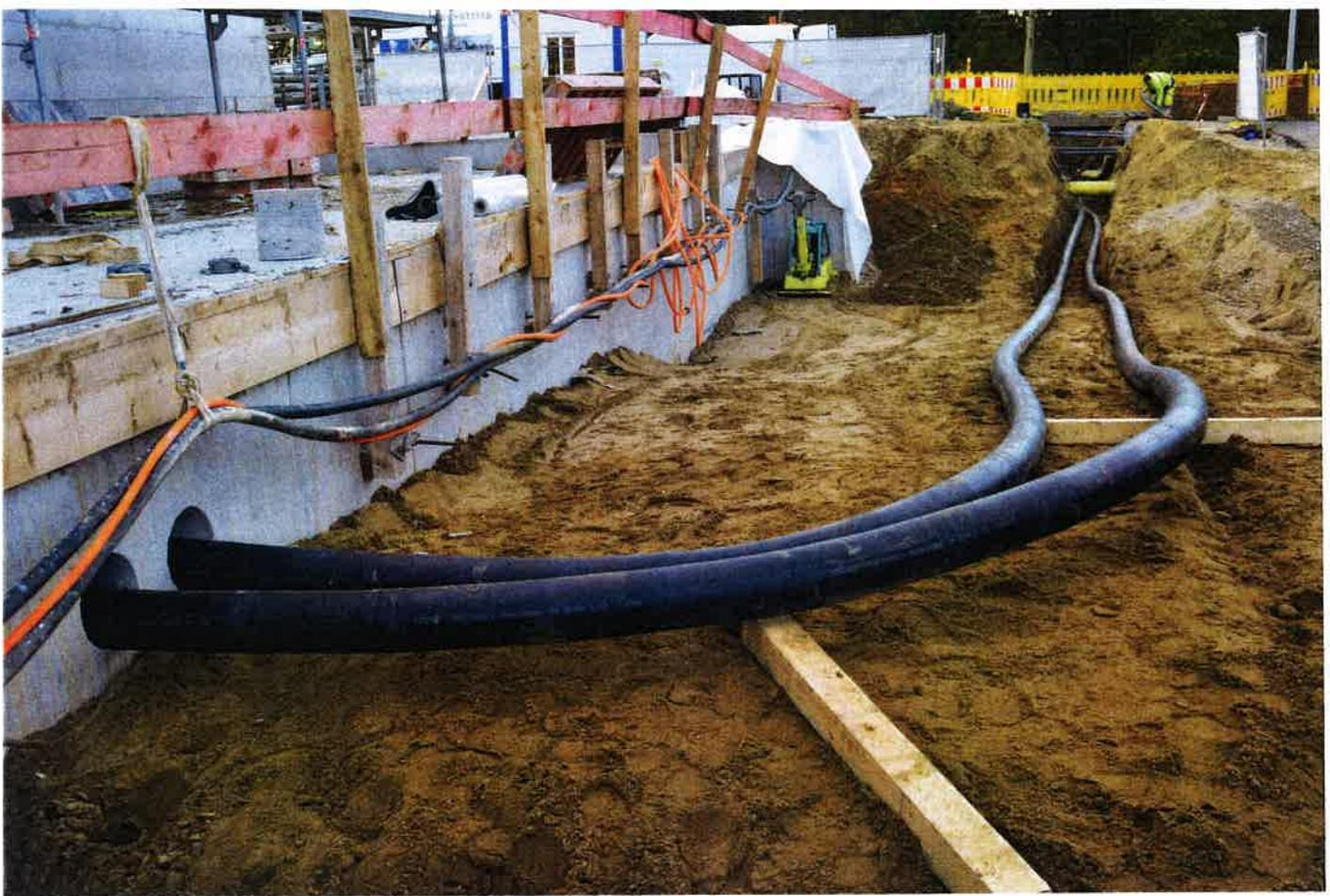
Einspeisepunkt in der Berckhusenstraße ausgehoben. Diese befand sich genau auf der anderen Seite der Karl-Wiechert-Allee und den parallel zur Straße verlaufenden Straßenbahngleisen. Das Bohrgerät musste also nur in der ersten Baugrube eingebracht werden und konnte von dort aus die entsprechenden Bohrungen für die Flexwell-Leitung vornehmen.
