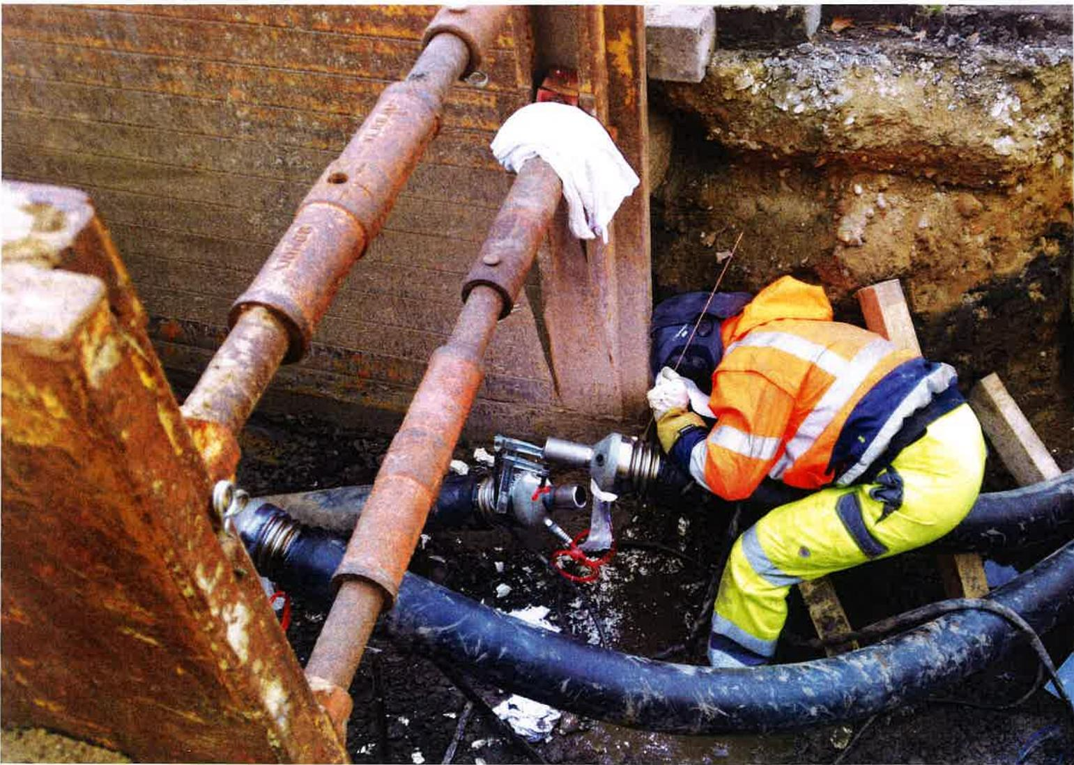
oder Kanälen auftauchten, konnten diese flexibel umgangen werden. Nachdem der Bohrkopf an der Zielbaugrube angekommen war, wurde beim Zurückziehen des Bohrgestänges gleichzeitig die Bohrung aufgeweitet. Eine zweite Bohrung mit etwa 20 bis 25 Zentimetern Durchmesser brachte die Pilotbohrung dann auf den für die Leitung passenden Durchmesser. Wiederum auf dem Rückweg des Bohrgestänges wurde an den Bohrkopf die Flexwell-Leitung angebracht
