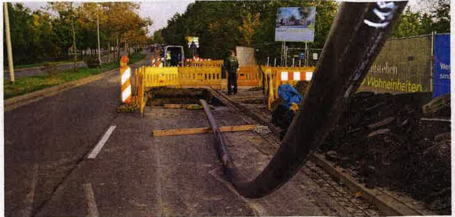
Foto: Brugg Rohrsysteme
