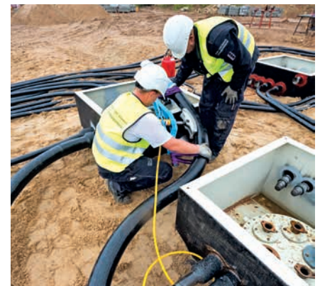
Biegen der Rohrleitung
