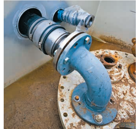
Fertig montierte Anschlussverbindung
