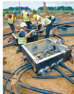
Einbringen der Füllleitung
