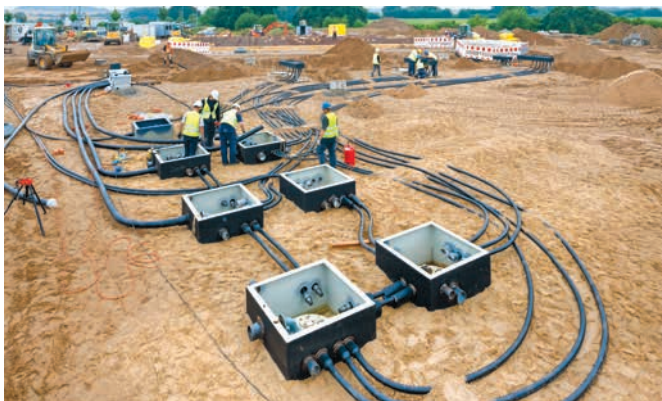
Gesamtansicht der Tankstellenbaustelle
