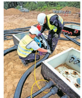
Biegen der Rohrleitung
