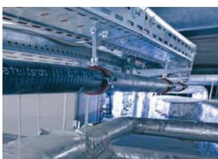
Einfache Fixierung der Rohrleitung mit Systemtechnik
