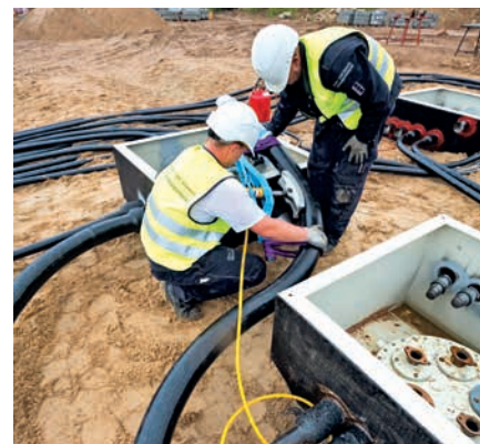
Biegen der Rohrleitung
