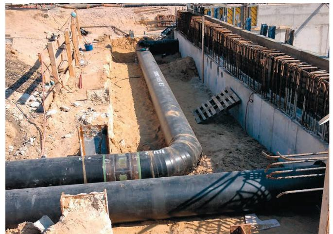
vollständig entkernt, saniert und ein Konzept zur Klimatisierung entworfen. Ein wichtiger Bestandteil der Klimaanlage ist das ca. 240 m entfernte Rückkühlergebäude. Für den Transport des Wasser-Glykol-Gemischs (WGK-1) kam für den Kunden nur ein Sicherheitsrohr in Frage. Aufgrund unseres DIBt-bauart-zugelassenen BRUGG-STAMANT®-Sicherheitsrohres und unseres gut ausgebildeten Verlegeteams, fiel die Wahl auf unser BRUGG-STAMANT®-
