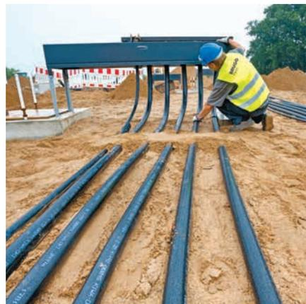
**SECON®-X - doppelwandiges, flexibles, metallisches Rohrsystem für unterirdische Kraftstoffleitungen im Tankstellenbau: DN 25-DN 100, PN 10**
