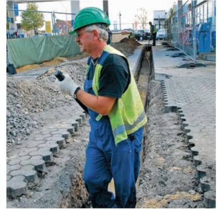
**FLEXWELL®-LPG - einwandiges, flexibles, metallisches Rohrsystem für unterirdische Kraftstoffleitungen im Tankstellenbau: DN 25-DN 50, PN 25**
