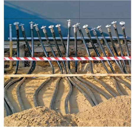
**PETREX®-CNT - einwandiges, flexibles, metallisches Rohrsystem für unterirdische Kraftstoffleitungen im Tankstellenbau: DN 25-DN 80, PN 10**
