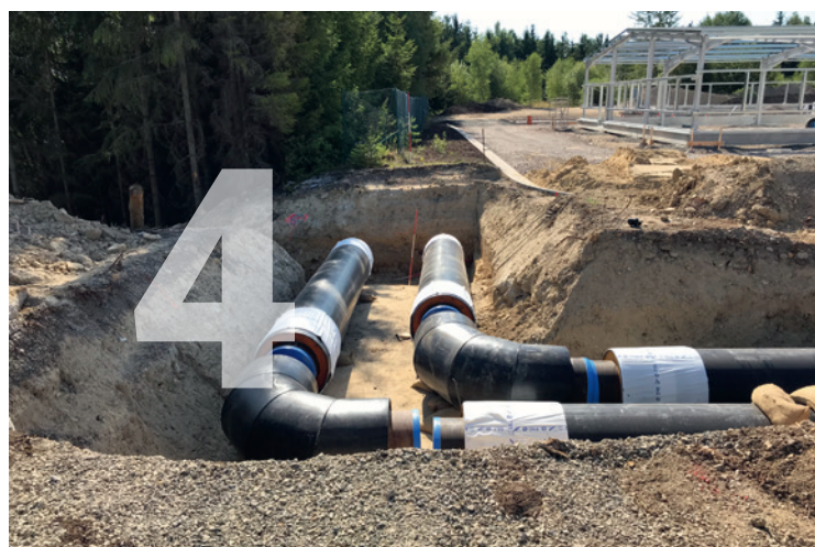
Mehr als 30 Jahre bleiben die Rohre im Boden – nicht nur das spricht für die Qualitätsprodukte
