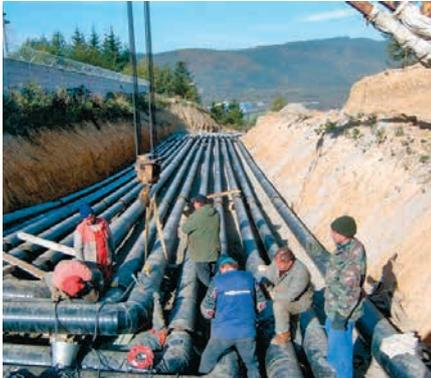
Montage des Außenmantels BRUGG-STAMANT®-Sicherheitsrohr
