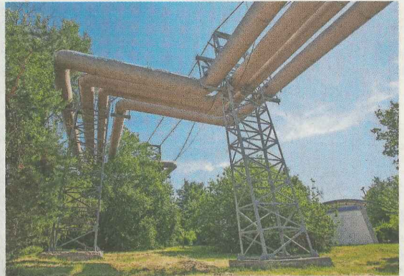
Die oberirdischen Fernwärmeleitungen sollen bis Jahresende verschwinden.
