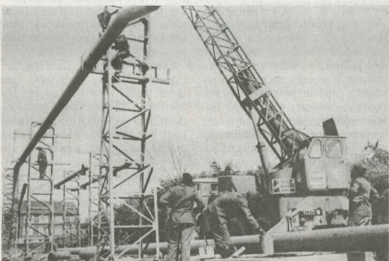
Polnische Werkätige verlegen in den 1970er Jahren die Rohrleitung für die Fernheizung in Richtung des Neubaugebiets am Stollen. Archivfoto: IWV
